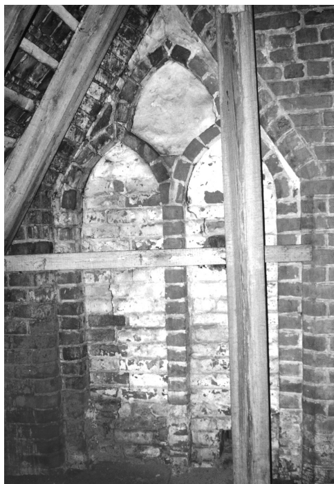
Ryc. 5. Trzebiatów, kościół NMP, blenda w dawnym szczycie zachodnim korpusu nawowego. Fot. M. Ober
